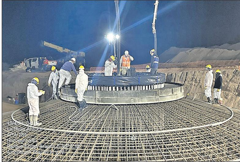
Los operarios en plena tarea de encofrado de una de las bases de los generadores.
