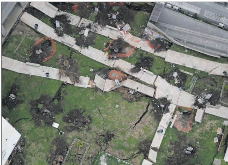
El derrumbe ocurrió en el barrio porteño de Parque Patricios.
